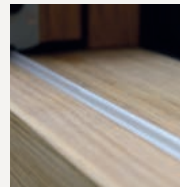
LAUFSCHIENE Lautloses Rollen der Integralschiebetür auf der im Holz eingelassenen Aluminiumschiene.
